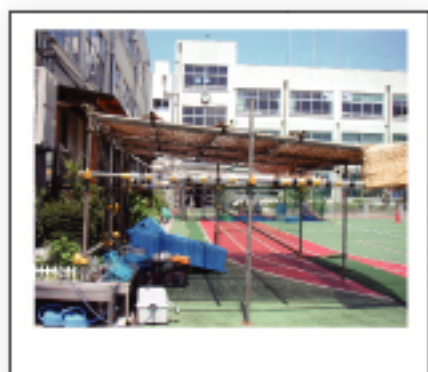
すだれを活用している 小台橋保育園
